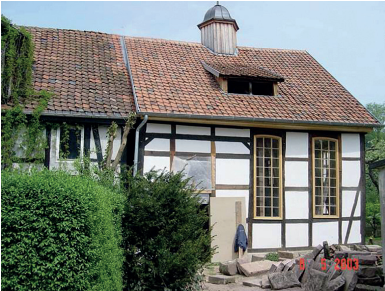
Die Synagoge in Harmuthsachsen während der Instandsetzungsarbeiten 2003. Das links angrenzende Gebäude wurde 2017 abgerissen. Seither ist die Wetterseite der Synagoge ungeschützt. 18 Der Dachreiter, der auf dem Foto von Thea Altaras noch nicht zu sehen war, ist ein Nachbau nach der einzigen bekannten Außenaufnahme des Gebäudes aus der Zeit, als es noch als Synagoge genutzt wurde.
