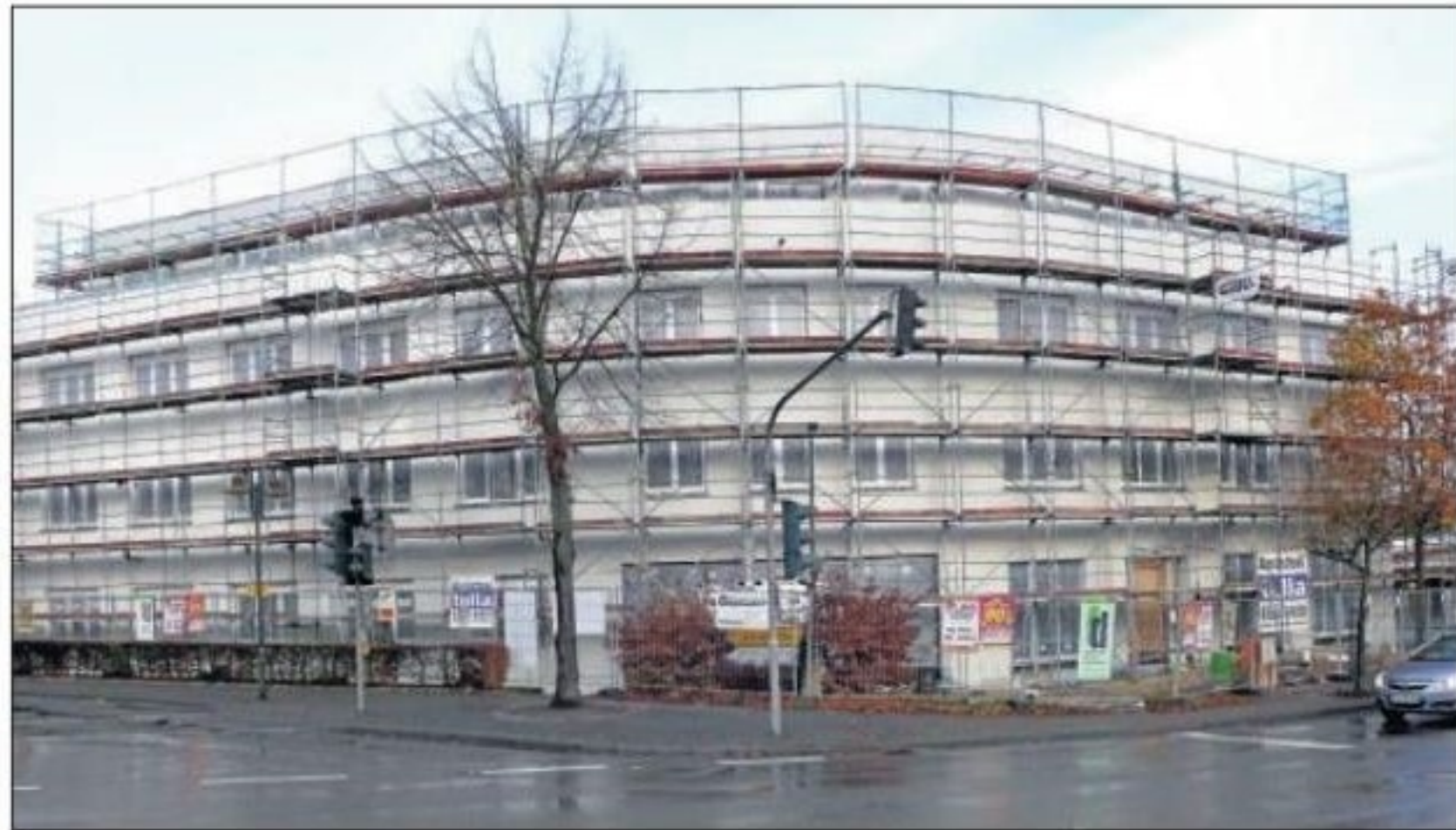
Abriss und Neubau: Bereits im Januar 2015 wurde mit dem Abriss der Obervellmarer Traditionsgaststätte begonnen. In wenigen Wochen soll der an gleicher Stelle errichtete Neubau des „Gesundheitszentrums Regenbogen“ bezogen werden.
