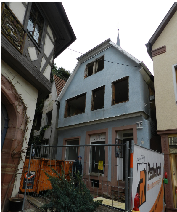
Abb. 25: Abbruch der ehemaligen Bäckerei Stern/Haaf. (Foto: Harth)
