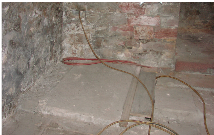
Abb. 6: Der Quellschacht im Keller des Wohnhauses von Samuel Selig (Foto: Harth)
