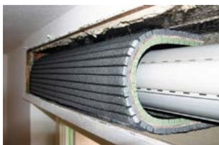
Abbildung 6: Rolladenkastendämmung<sup>6</sup>
