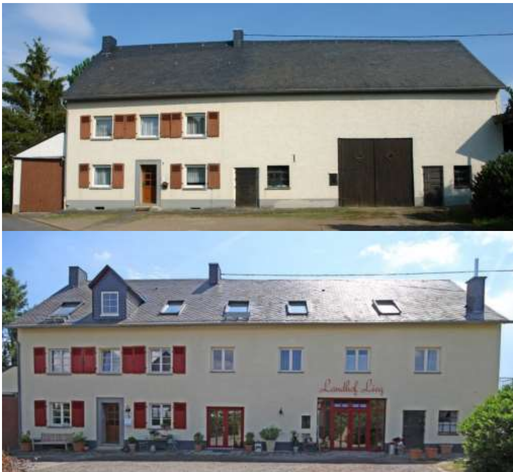
Abbildung 13: Beispiel einer Förderung aus dem Programm Dorferneuerung (KREISVERWALTUNG COCHEM-ZELL)
