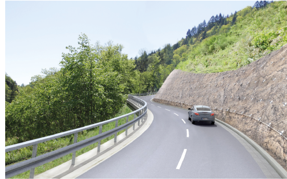
BLICK AUF DIE KÜNFTIGE BERGSTRECKE
