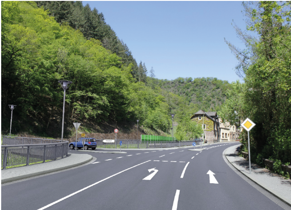
BLICK VON DER ENDERTSTRASSE AUF DIE NEUE EINMÜNDUNG L 98/K 18 MIT DER NEUEN BRÜCKE
