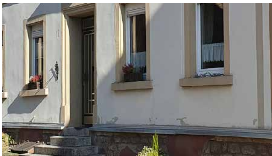
Gebäude mit mittlerem Sanierungsbedarf in der Ortsgemeinde Heiligenmoschel, VG Otterbach-Otterberg (Foto: Kernplan)
