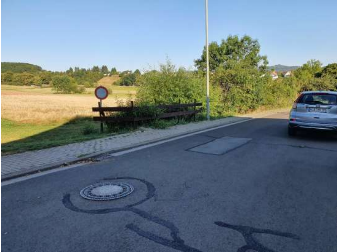
Abbildung 3: Ansicht Überfahrt 1 von der Straße „Zum Petersberg“
