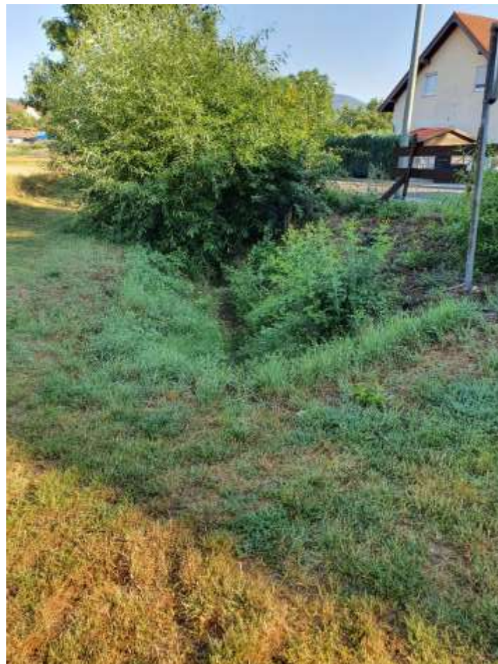
Abbildung 2: Ansicht Überfahrt 1 von Süden
