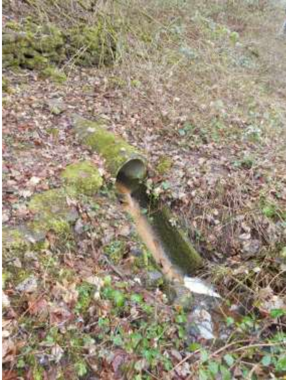
Bild 1.9.1: best. Auslauf, RW-Kanal in ein namenloses Gewässer
