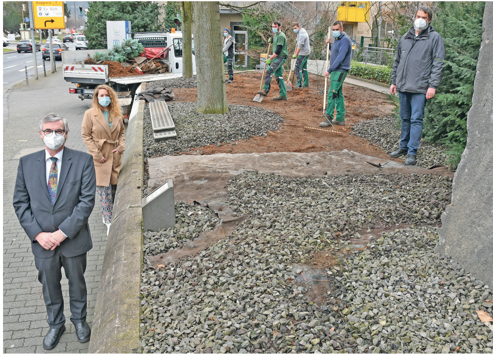
Landrat Dr. Alexander Saftig (links) freut sich gemeinsam mit Kerstin Kopp, Referatsleiterin für das Gebäudemanagement, und Dr. Rüdiger Kape (rechts), dass die Umgestaltung der Außenanlagen der Kreisverwaltung am Friedrich-Ebert-Ring begonnen hat. In einem ersten Arbeitsschritt entfernten Auszubildende des Eigenbetriebes Grünflächen- und Bestattungswesen der Stadt Koblenz (Hintergrund) den Schotter im Beet vor dem Kreishaus.
