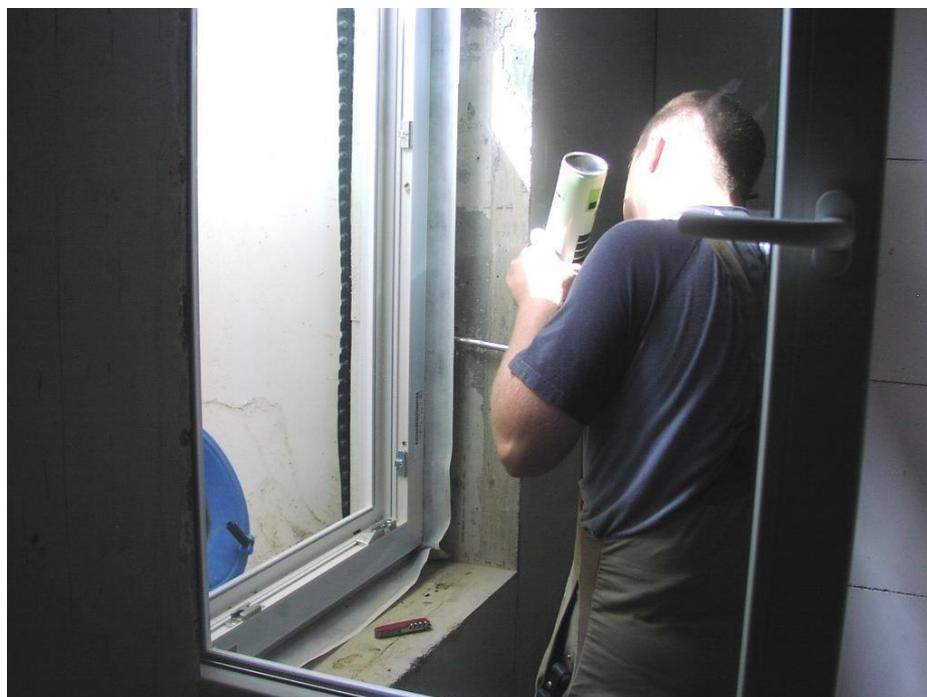
**Bildunterschrift Foto:** Montageschaum reicht beim Einbau neuer Fenster nicht aus – der Rahmen muss luftdicht in der Leibung verklebt werden.
