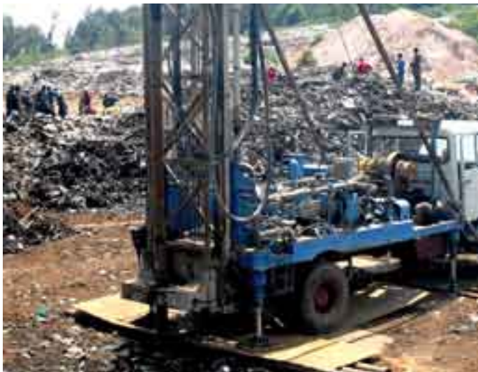
Bohrgerät mit Kompressor am nördlichen Bohransatzpunkt der Mülldeponie in Kigali (Foto: Daniel Kehrer, wat Mainz).
