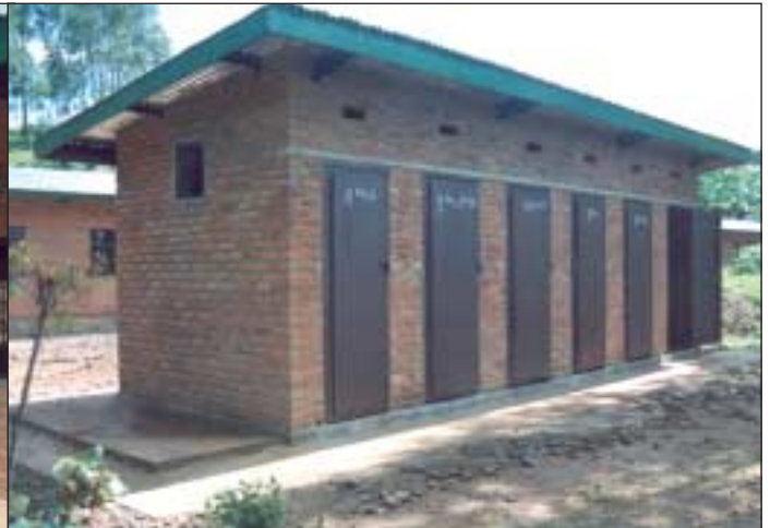
Auch sechs neue Latrinen wurden in Gahati errichtet.
