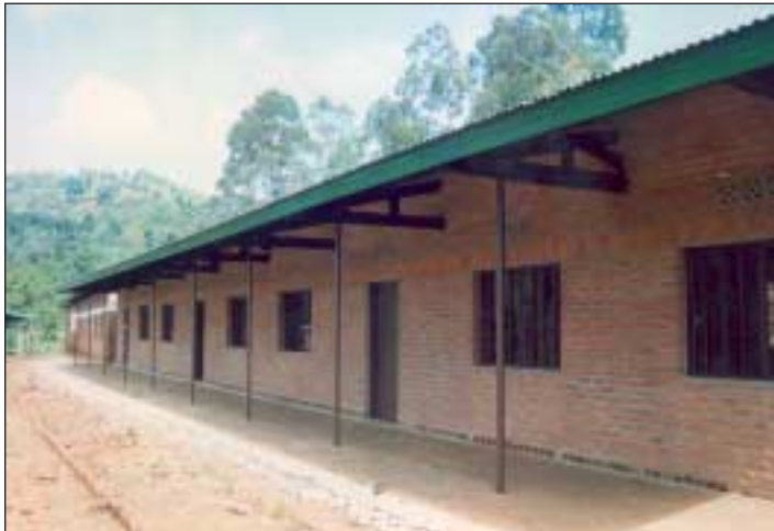
Gebäude mit drei von sechs neuen Klassenräumen in Gahati.
