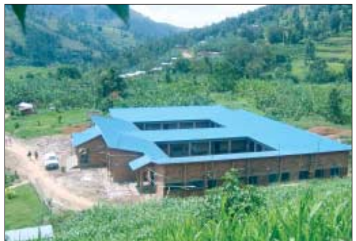
Neubau des Centre de Santé Cyondo mit Unterstützung des Kreises Bitburg-Prüm. (Foto: Koordinationbüro Kigali)
