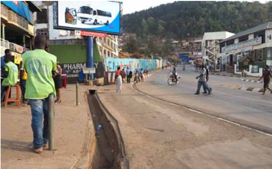
So mancher entsorgt seine Abfälle in den Entwässerungskanälen, was zur Verstopfung dieser Kanäle führen kann (Foto: Kind).
