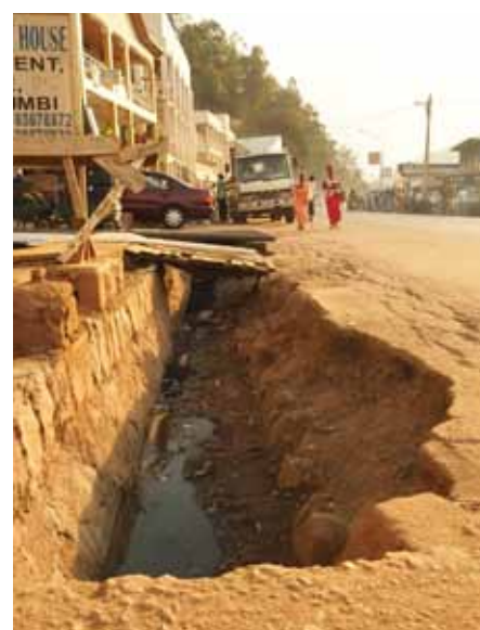
Offene Abwasserkanäle bestimmen das Stadtbild von Kigali (Foto: Kind).
