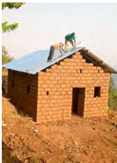
Der Wiederaufbau der Häuser konnte noch vor Beginn der neuen Regenzeit beendet werden (Fotos: Abbé Valens Twagiramungu).
