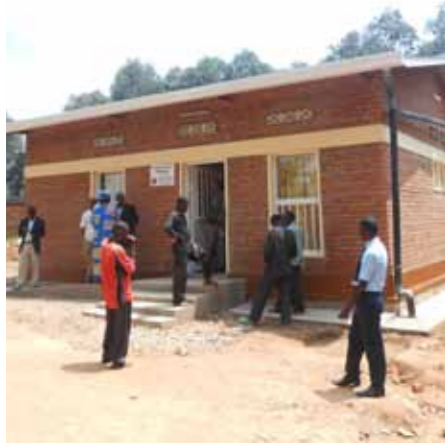
Fertiggestellte Krankenstation an der Groupe Scolaire Janja (Foto: Koordinationsbüro).
