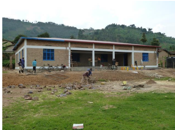
Baustelle des Berufsausbildungszentrums Mushongi, Distrikt Rulindo
