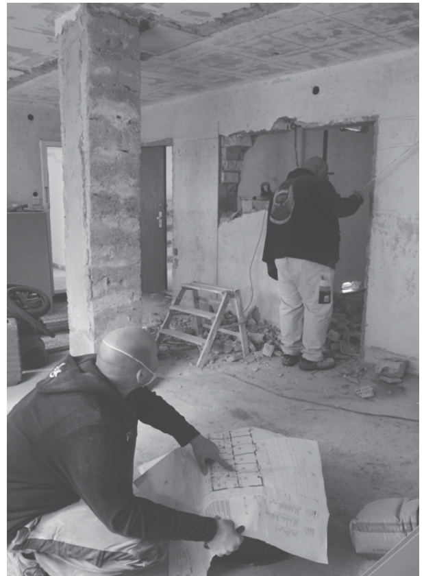
In der Wohnung war ein Totalumbau erforderlich.
