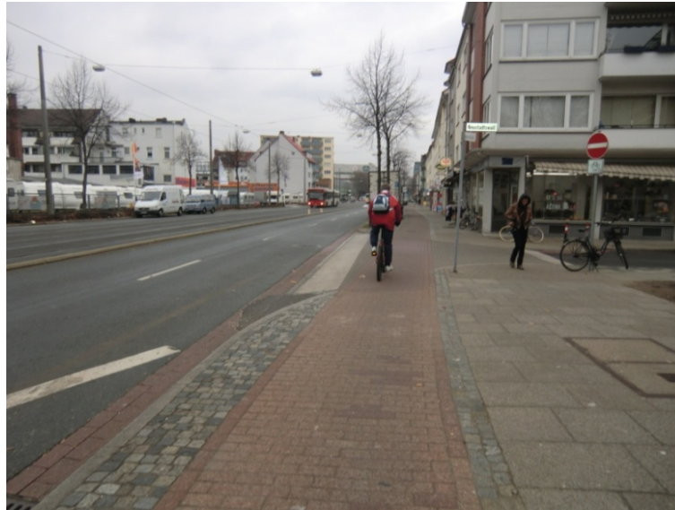
Abb. 4-11: Teilaufpflasterung im Einmündungsbereich einer Nebenstraße (Bremen)
