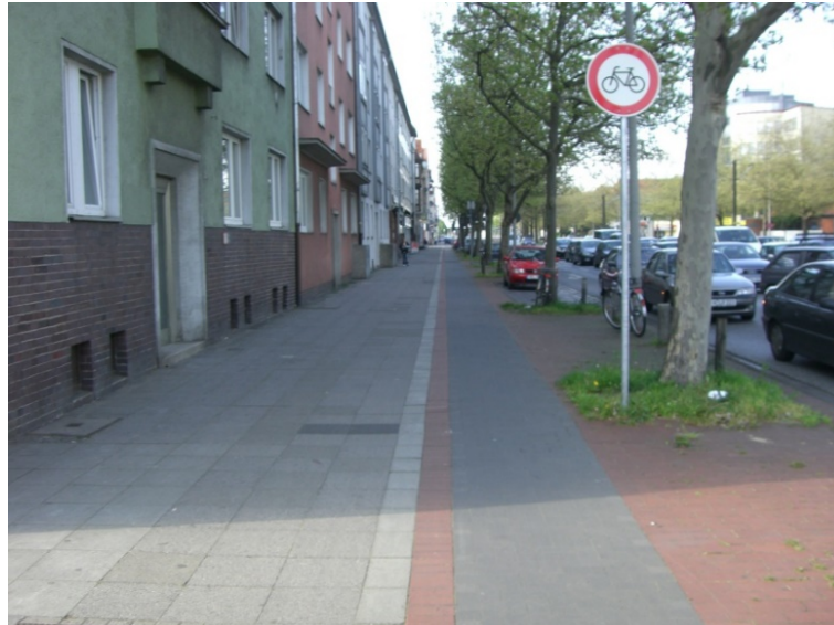
Abb. 6-4: Verdeutlichung des Endes eines Zweirichtungsradweges durch Z 245 StVO (Hannover)
