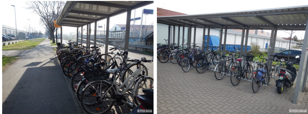
Abb. 7-24: Anforderungsgerechte, überdachte Rahmenhalter am Haltepunkt Speyer Nord
