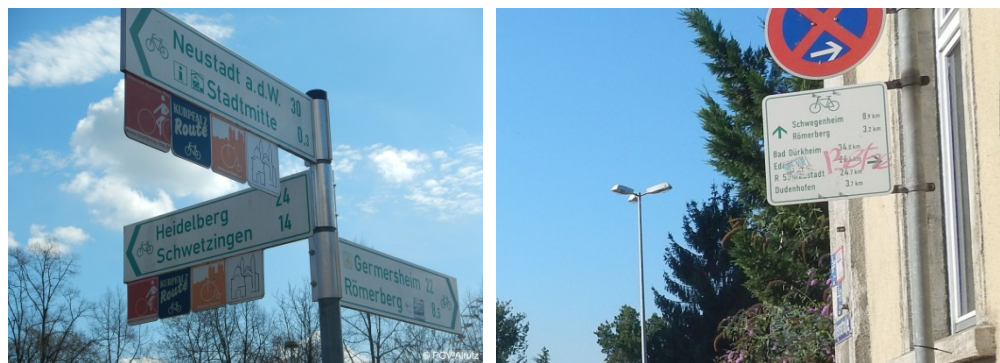
Abb. 5-3: Anforderungsgerechte Wegweisung gemäß FGSV-Merkblatt 12 (links) und „Altlasten“ bezüglich Radwegweisung (rechts)
