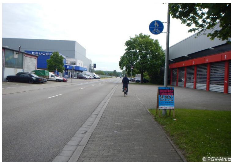
Abb. 4-9: Gemeinsamer Geh- und Radweg (Heinkelstraße, Speyer)
