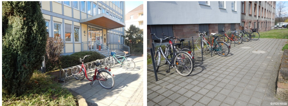
Abb. 7-14: Vorderradhalter an der Agentur für Arbeit (links) und Anlehnbügel am Vincentius-Krankenhaus mit zu geringem Abstand (rechts)
