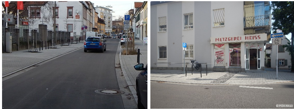
Abb. 7-10: Neu installierte Anlehnbügel im Zuge der Armbruststraße - Johannesstraße
