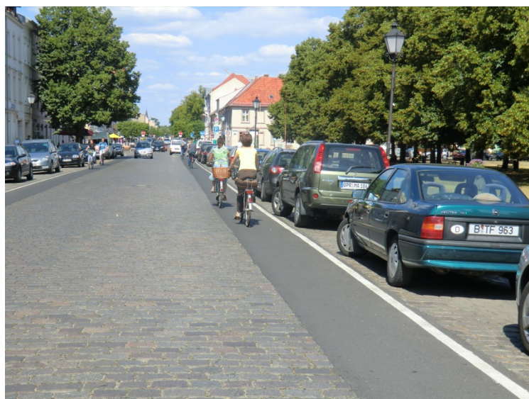
Abb. 6-5: Pflasterstreifen zur Verbesserung des Fahrkomforts (Neuruppin)
