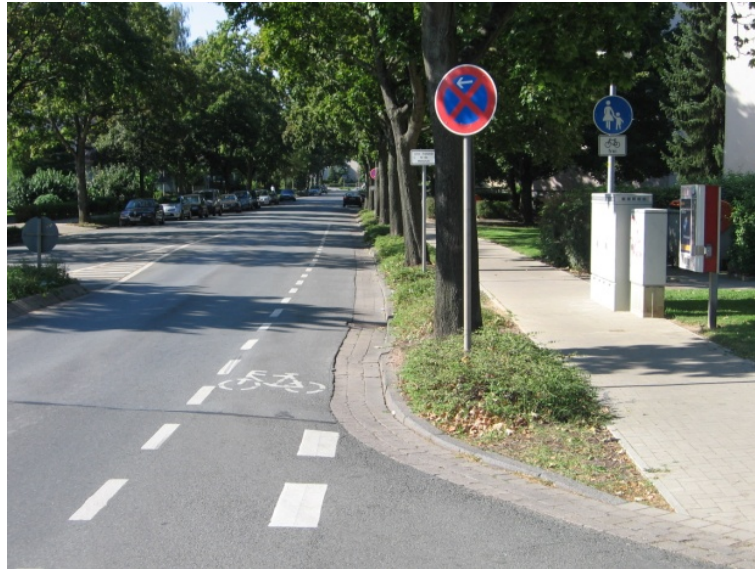
Abb. 4-8: Kombination von Schutzstreifen mit Gehweg, Radverkehr frei (Hameln)
