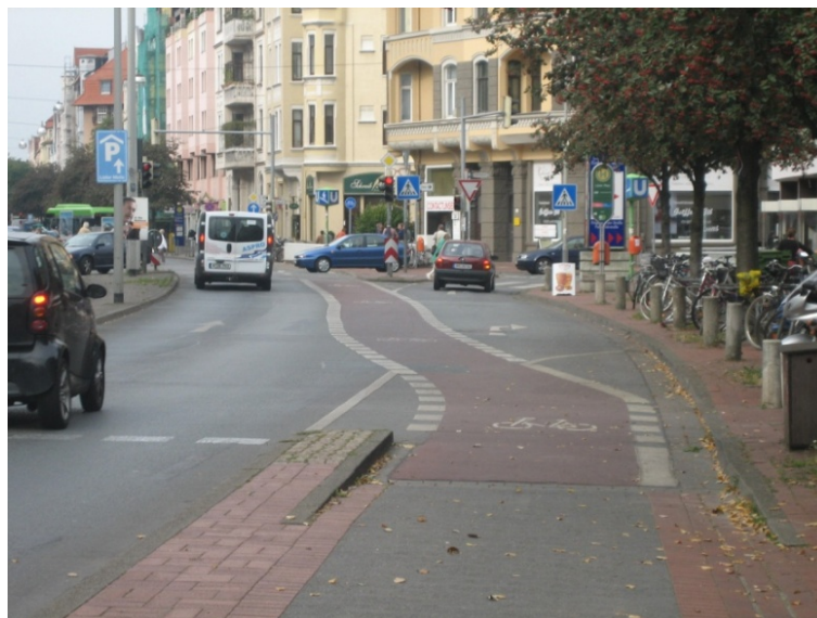
Abb. 4-12: Übergang Radweg in Radfahrstreifen an signalisiertem Knotenpunkt (Hannover)
