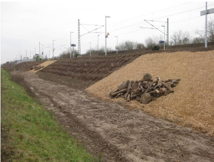
Abbildung 8: Beispiel einer reptiliengerecht gestalteten Bahnböschung
