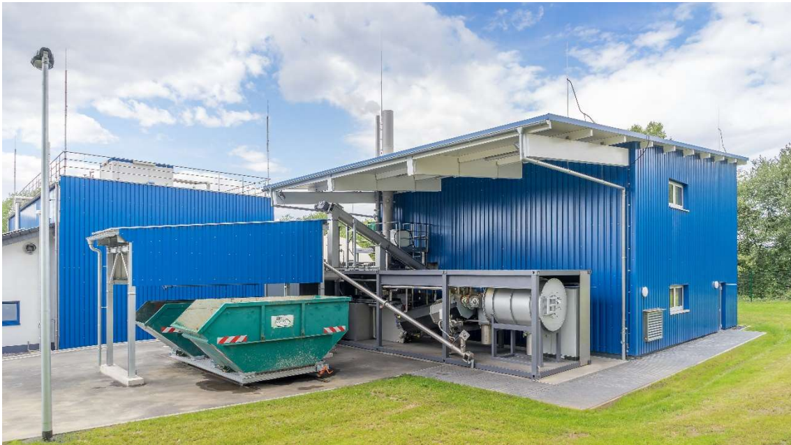
Abb. 17: Pyreg-Anlage und Schlammbehandlungsgebäude
