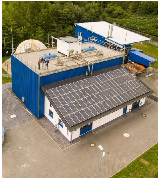
Abb. 11: Kompaktfaulung mit Technikgebäude
