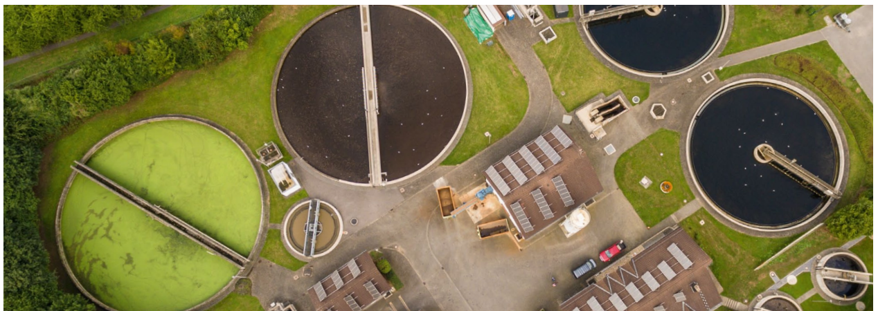
Altbestand der Kläranlage Linz-Unkel
