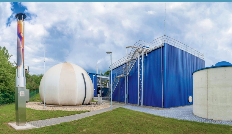
Gasbehälter und 2-stufige Kompaktfaulung
