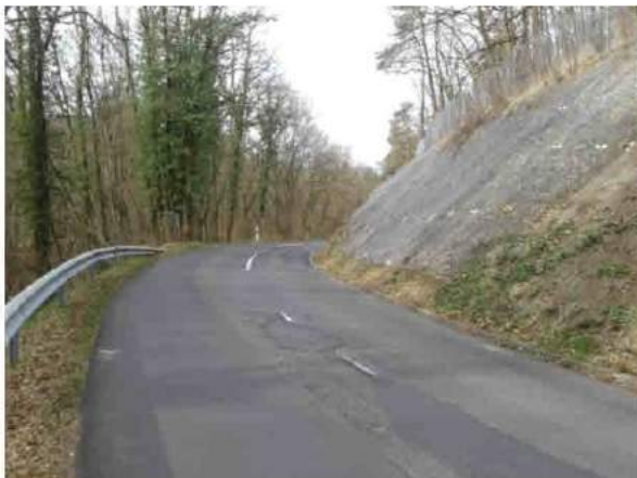
Hangsicherungsbereich mit Stahlnetz-sicherung
