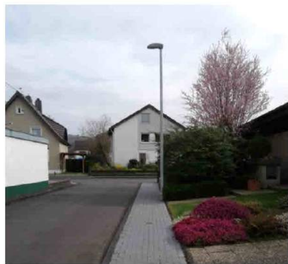
Gehweganlage mit neuer LED-Straßenbeleuchtungsanlage und eingebauten Medienleerrohr
