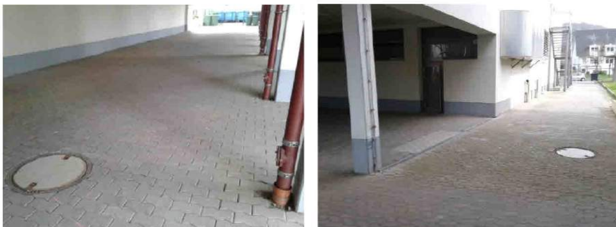
Anbindung der Regenentwässerung unter dem Vordach und der neuen Grundleitung an den Hauptkanal
