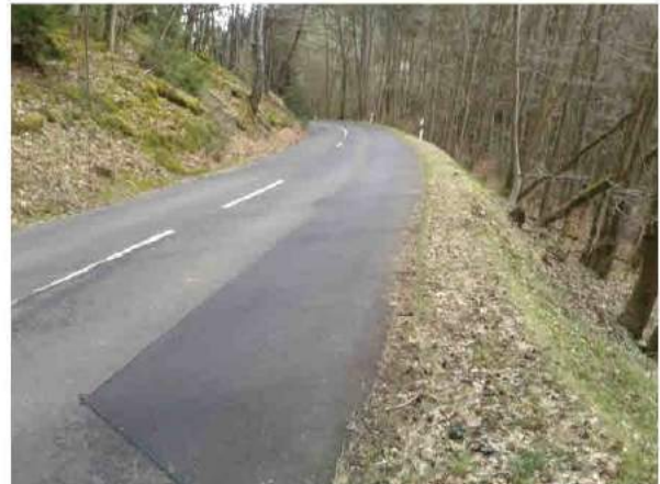
Straßenstabilisierung mit Böschungsertüchtigung
